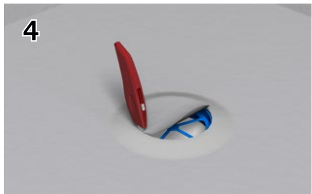
4 Efter det att tätmembranet torkat skärs brunnsmanschetten upp.
